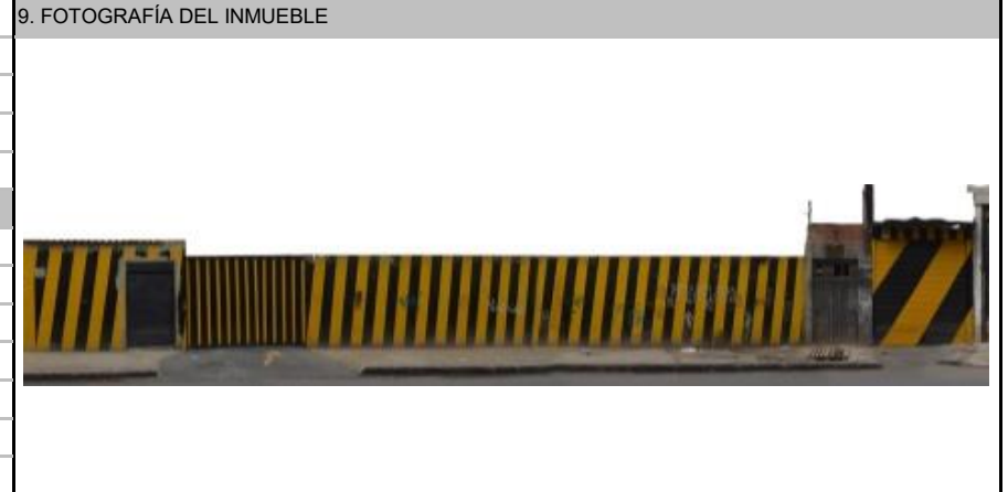
Fuente: Equipo Fotografía PEMP Patrimonio Inmueble
